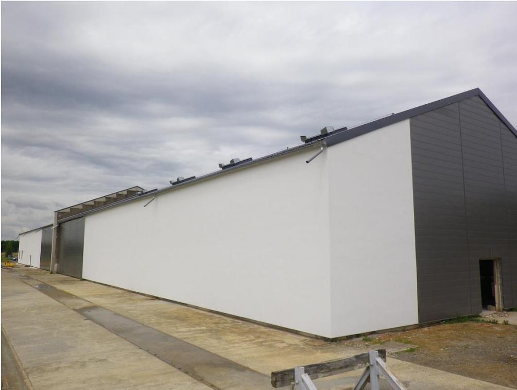
Réhabilitation de deux bâtiments de stockage en polystyrène ep 170 mn pour **2200 m<sup>2</sup>**
