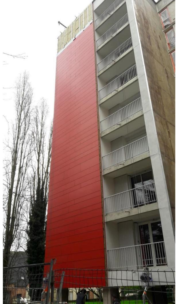
***Bardage en panneaux rockpanel ep 8 m sur ossature Alumium et
