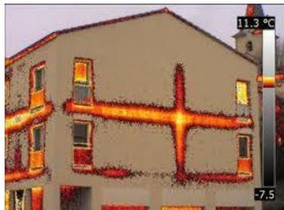
L'isolation thermique par l'extérieur (I.T.E.) enveloppe le bâti dans une "double peau" isolante et décore les façades
